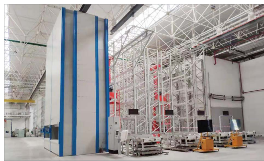
图10 自动化仓储立体库
